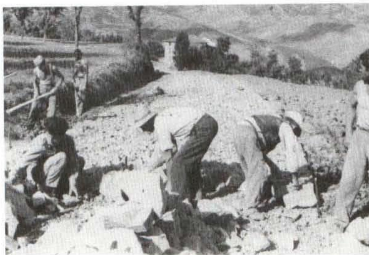
L'inizio dei lavori per fornire l'acqua tanto preziosa al Comune di Prignano.
